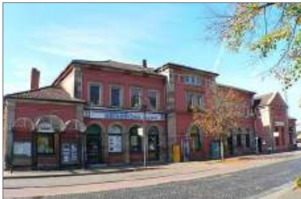
Abb. 16: Empfangsgebäude (vorher) (Foto ANP)
