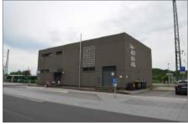
Abb. 21: Stellwerk der DB AG nach Sanierung (Foto ANP)
