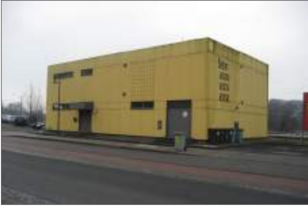
Abb. 20: Stellwerk der DB-AG (vorher) (Foto ANP)
