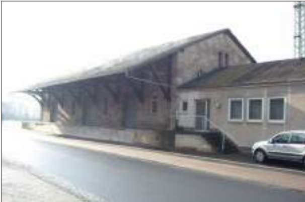
Abb. 24: ehem. Güterhalle vor dem Umbau (Foto ANP)
