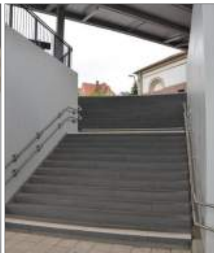
Abb. 11: Neue Treppe zur Unterführung (zur Stadt) (Foto ANP)
