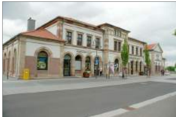
Abb. 17: Empfangsgebäude nach Sanierung (Foto ANP)
