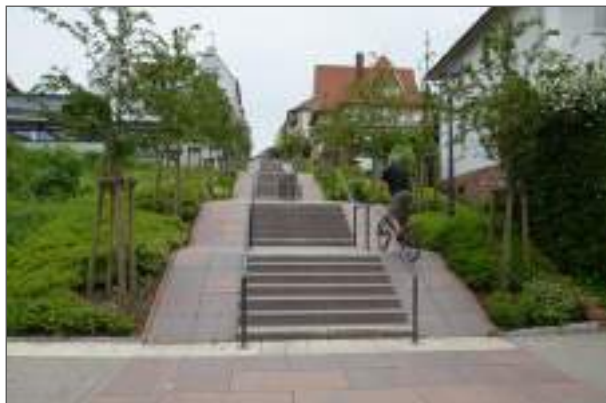
Abb. 42: Neue Anlage mit zeitgemäßem Treppen-Schrittmaß und sanften Rampen (Foto ANP)
