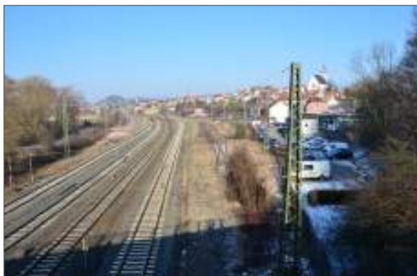
Abb. 39: Bereich für einen ‚Grünstreifen Ost‘ (von Süden, Foto ANP)
