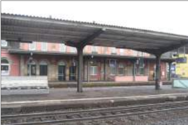
Abb. 14: Empfangsgebäude Gleisansicht (vorher) (Foto ANP)
