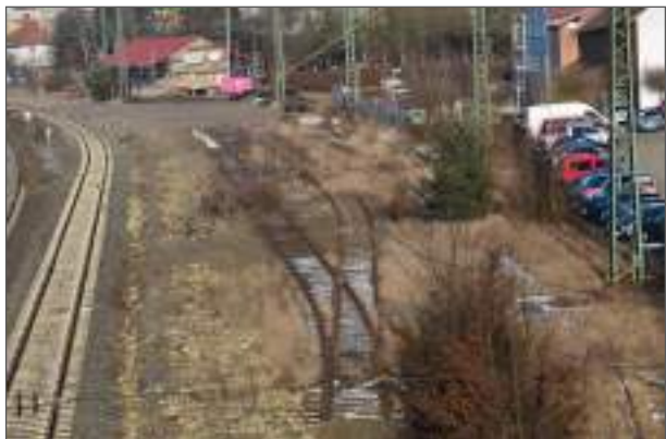
Abb. 37: Bereich des Gleisrückbaus (Foto ANP)
