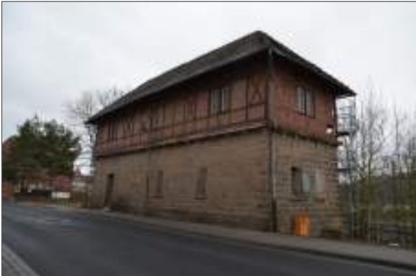
Abb. 30: ehem. „Wasserturm“ an der Gartenstraße (vorher) (Foto ANP)
