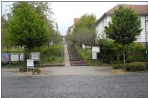
Abb. 41: Treppe am Rathausberg (vorher) (Foto ANP)
