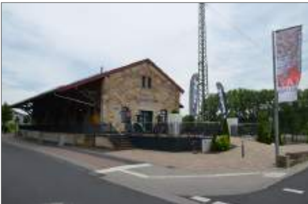
Abb. 26: ehem. Güterhalle nach Umbau (Vorplatz und Eingang, Foto ANP)
