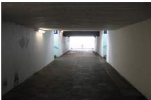
Abb. 5: Alte Unterführung (Foto ANP)
