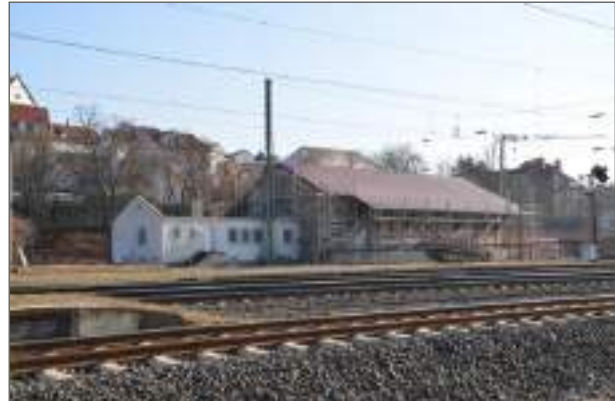
Abb. 25: ehem. Güterhalle im Umbau (Abbruch Sozialanbau, Foto ANP)
