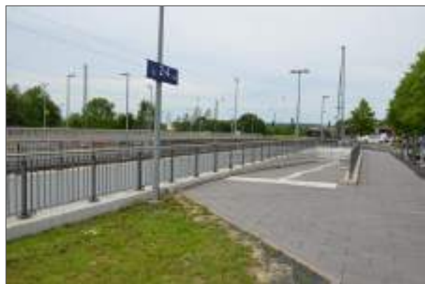
Abb. 13: Neue Rampe zur Unterführung / zur Stadt (Foto ANP)
